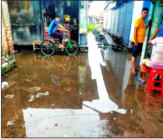
Drain -23, Kumarkhali Pourashava
