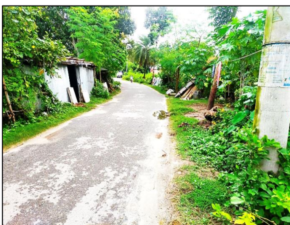
Drain-05, Kumarkhali Pourashava
